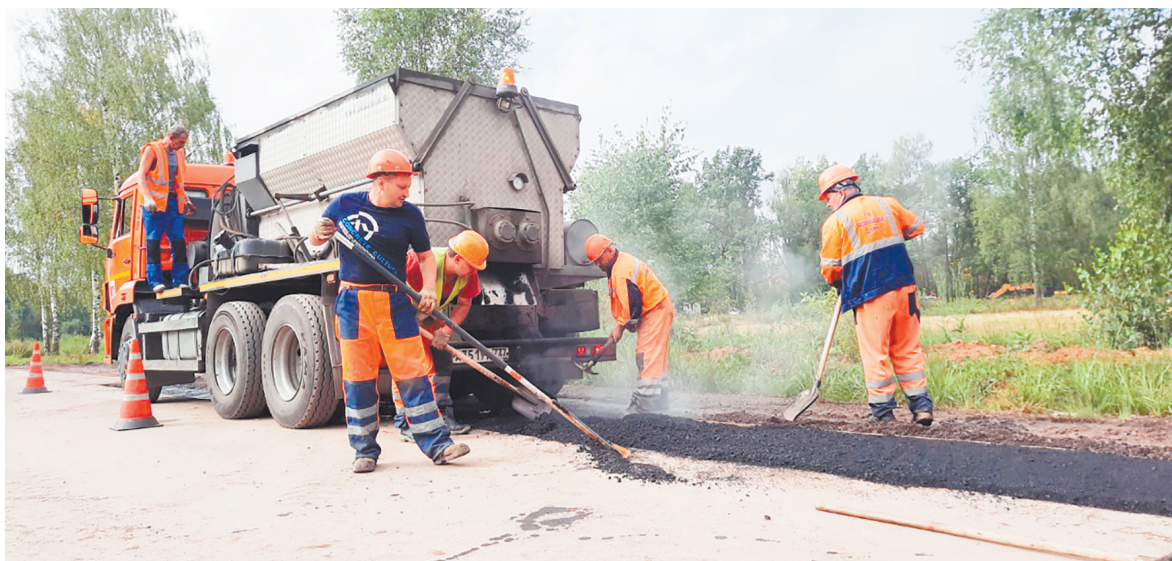
Дорожные работы в деревне Ярцево
